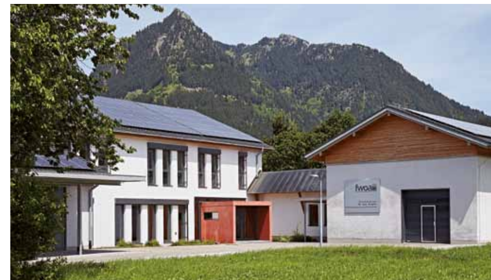
Das Betriebsgebäude der FWOA liegt auf der grünen Wiese und unter dem Wächter des Allgäus, dem Grünten.
